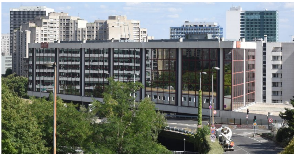
L'immeuble Le Linea en août 2016 - Defense-92.fr
