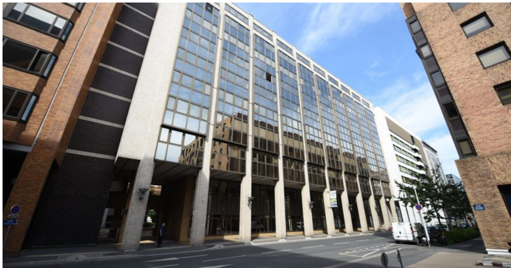
L'immeuble MB6 à Nanterre en juillet 2017 - Defense-92.fr
