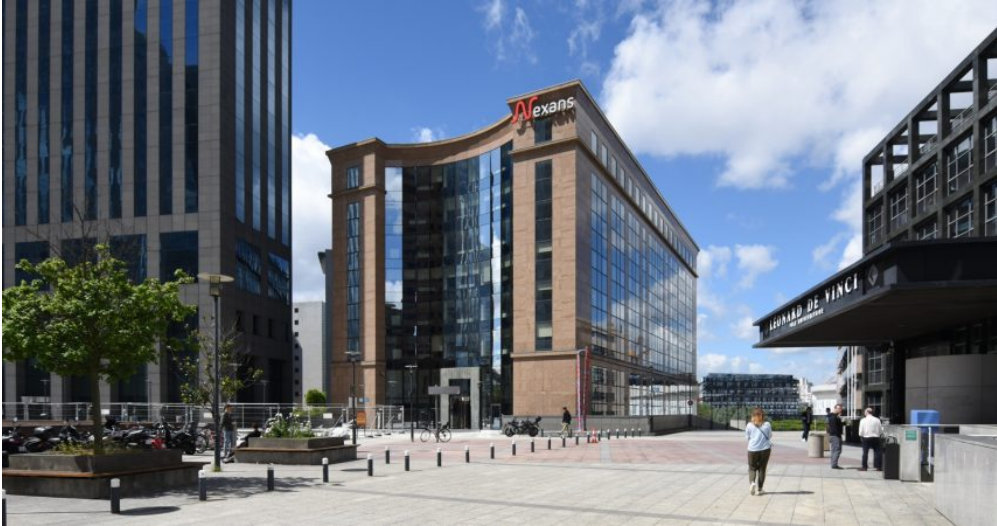
Le nouveau siège de Nexans dans l'immeuble le Vinci - Defense-92.fr
