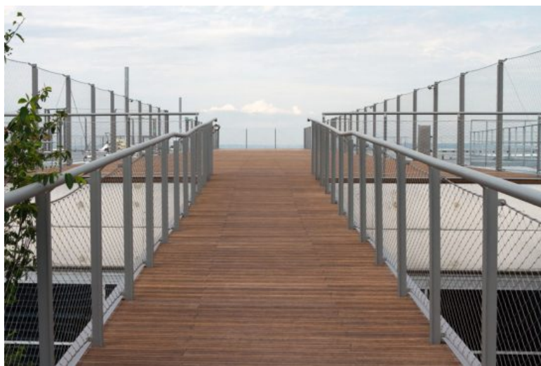
© Riad Kneife - Le pont promenade de 110 m de long sur 10 m de large, a été créé de toutes pièces en lieu et place de l'ancienne piste d'atterrissage.
